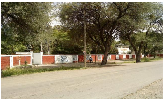
Fachada Exterior Instalaciones Prefabricadas
