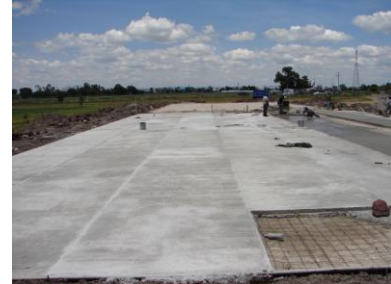
Canchas de usos múltiples. (Obra en proceso)
