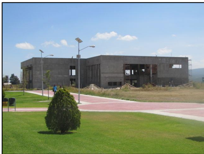
Foto 3: Avance edificio de Biblioteca
