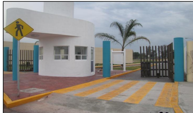
Foto 4: Avance del acceso principal
