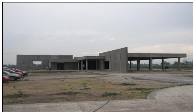
Foto 3 Avance Edificio de Cafetería
