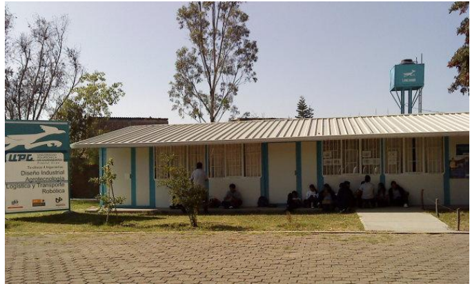
Figura No. 1. Instalaciones provisionales del plantel de Silao.
